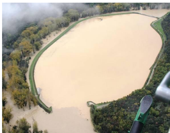
Fig. 2.32 Casse d'espansione in derivazione sul Torrente Chiani, durante la piena di novembre 2012
