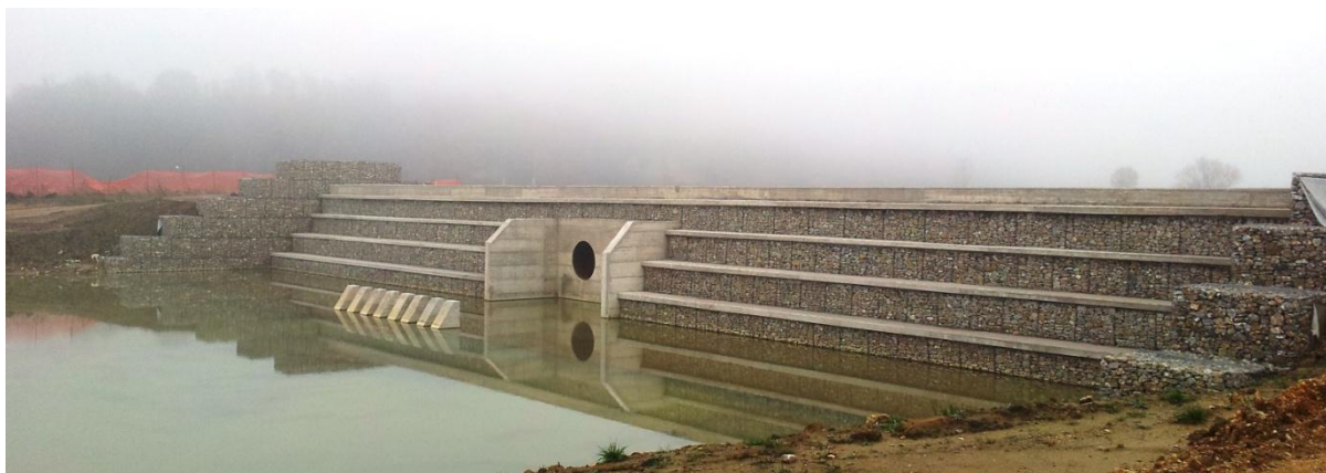
Fig. 2.33 Sfiatore di valle della cassa d'espansione sul T.Tresa in corso di costruzione
