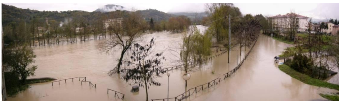
Fig. 2.4 Panoramica dal ponte di Ponte Pattoli che mostra l'esondazione del fiume Tevere
